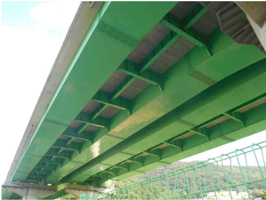
Steel Box Girder 외부 전경
