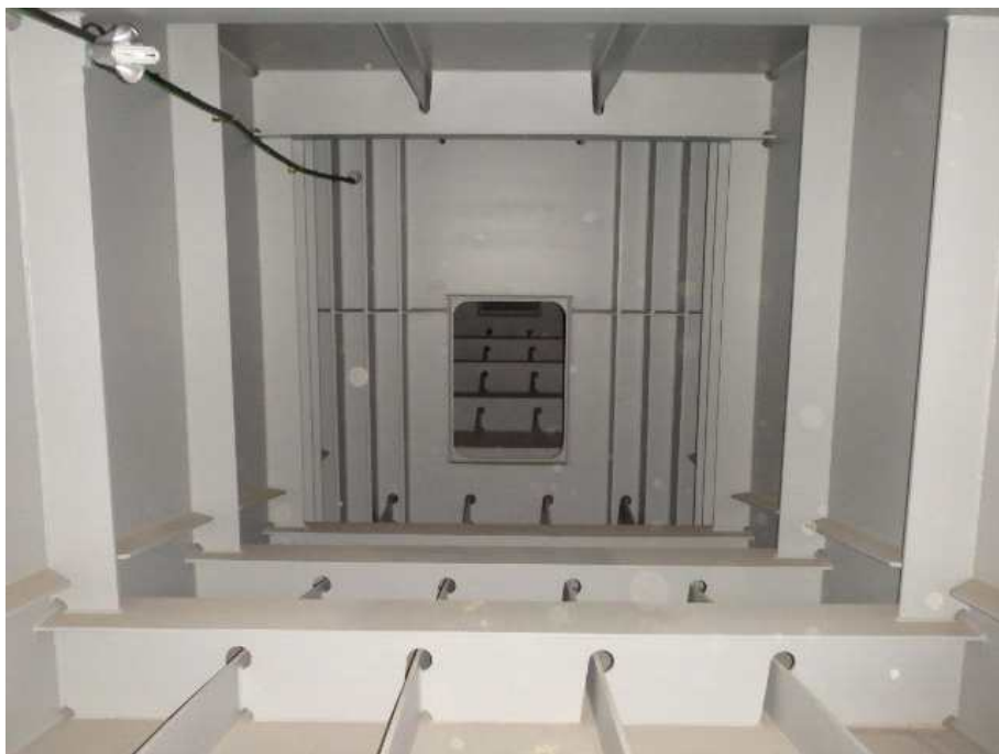
Steel Box Girder 내부 전경
