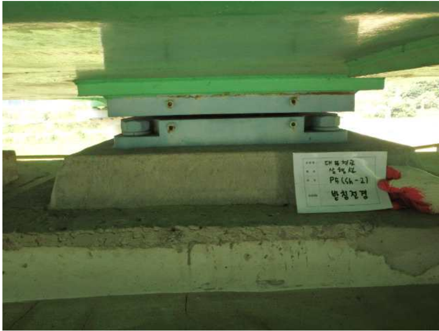
받침장치 전경 (고정단)
